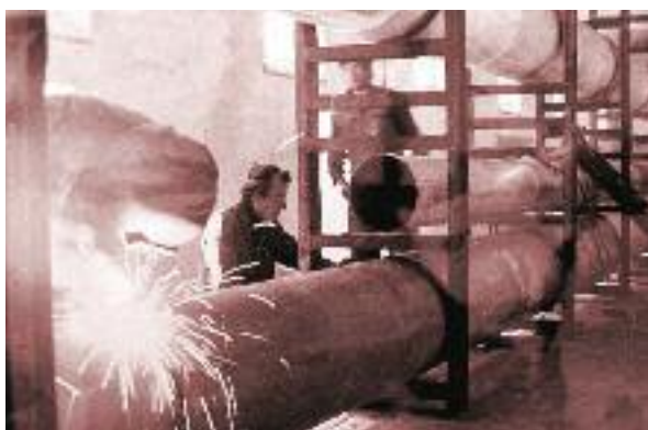
Technológiai gépház pinceszint csőszerelési munkái
