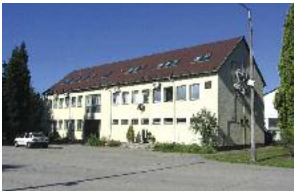
Üzemviteli és laboratórium épület (2007)
