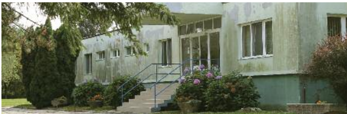
Üzemviteli és technológiai épület a Molnári vízműtelepen
