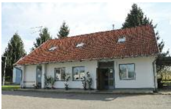
Csurgó, szennyvíztisztító telepi üzemviteli épület
