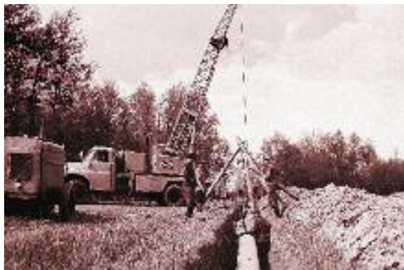
MURA I. távvezeték építése
