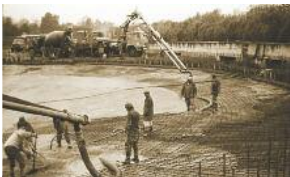
Utóülepítő medence építése
