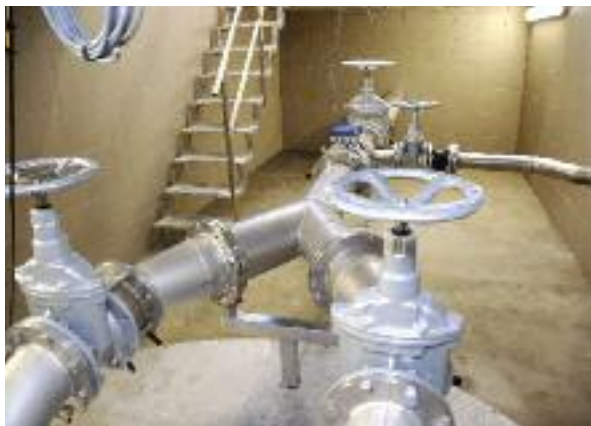
C-2 jelű törpe csáposkút gépészet
