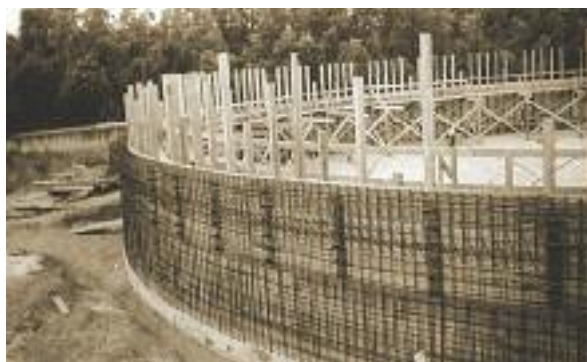
Utóülepítő medence építése
