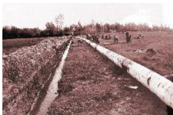
Nyersvíz gyűjtővezeték építése a csőkutaktól
