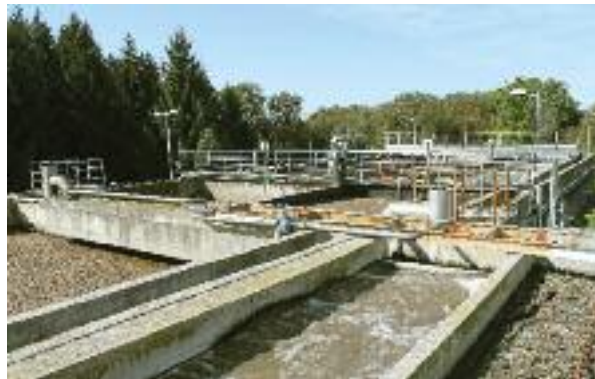
Csurgó, szennyvíztisztító telepi kombinált biológiai műtárgy
