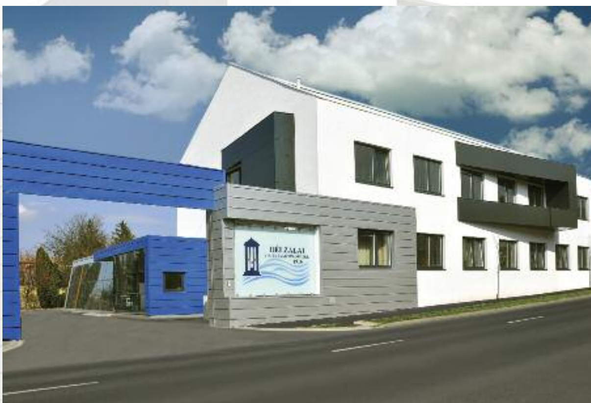
A Délzalai Víz- és Csatornamű ZRt. Kisfaludy utcai központja Nagykanizsán
