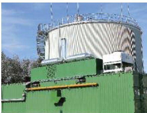
Rothasztó torony, előtérben a gázmotorok konténerházával
